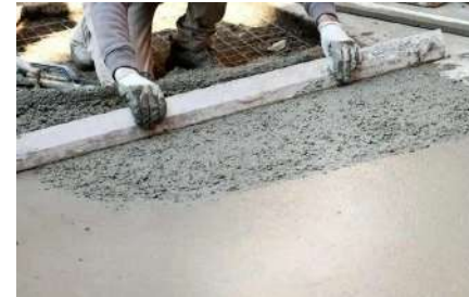
Ilustrasi pekerjaan rabat beton
