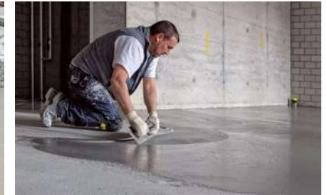
Aplikasi lantai kerja (Floor screed)
